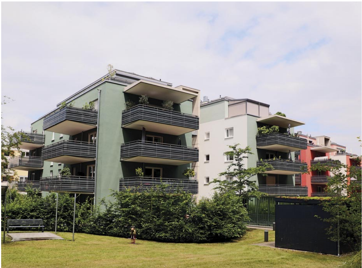
Bild: WIE 62 Paul-Kellerstraße 13-19 Grünanlage
