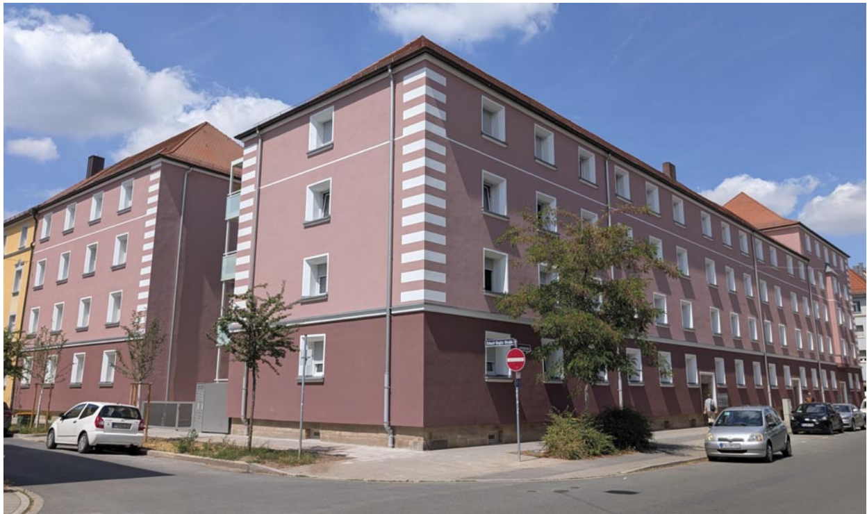
Bild: WIE 02 Straßenansicht
