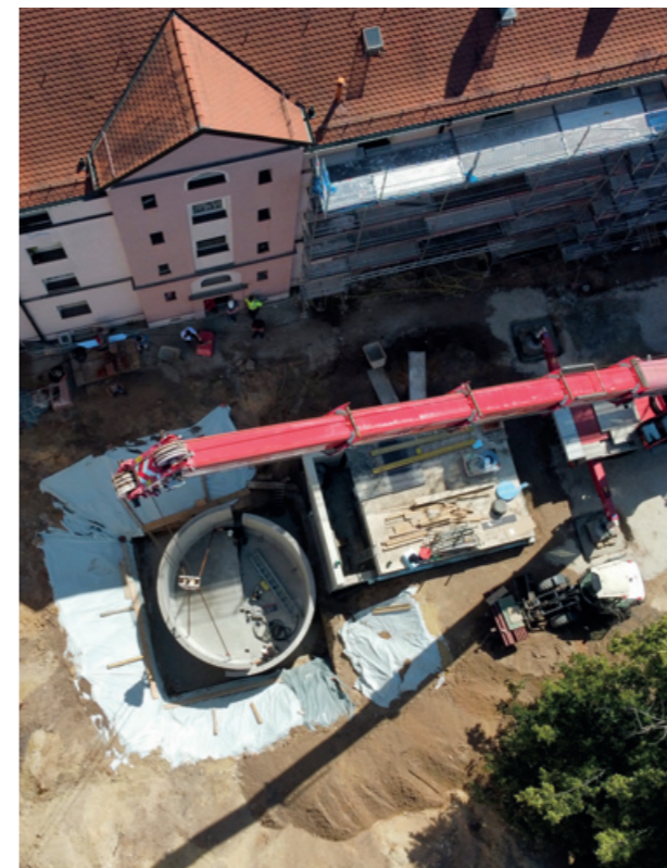
Bild: WI 2 Einsetzen Pellet-Speicher
