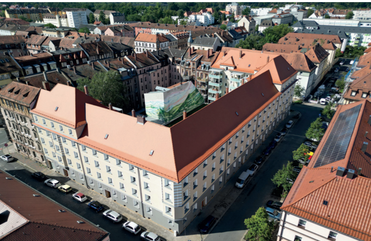
Bild: WI 3 Straßenansicht nach Modernisierung
