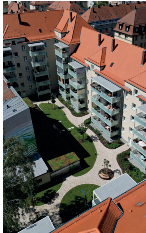
Bild: WI 3 Hofansicht nach Modernisierung
